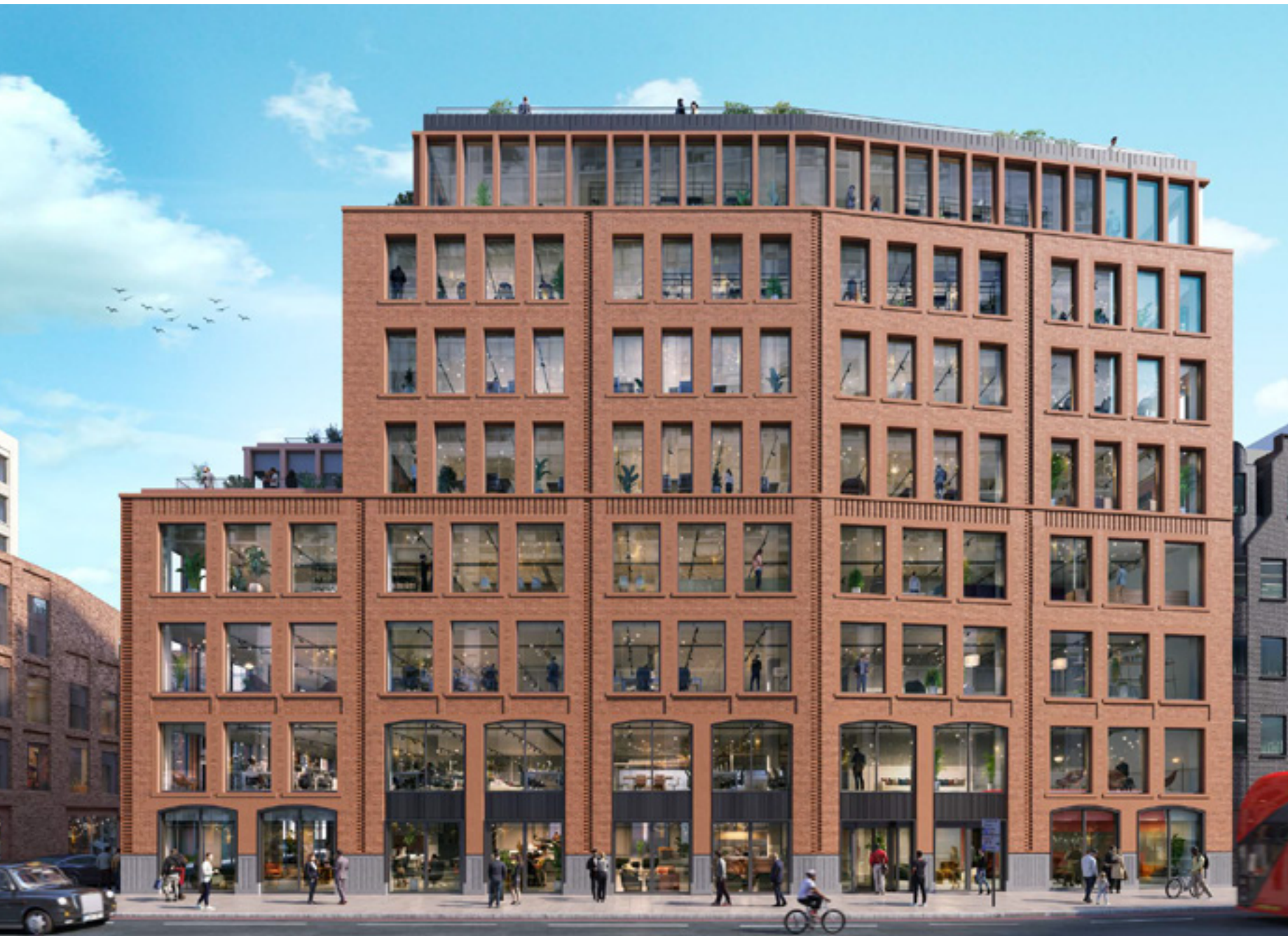
FOLGATE BUILDING LONDON E1
